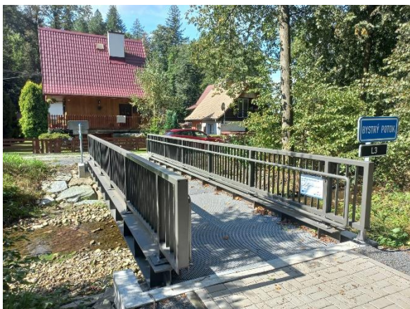
Obrázek 10 LÁVKA PRO PĚŠÍ PŘES BYSTRÝ POTOK – Obec Pržno
