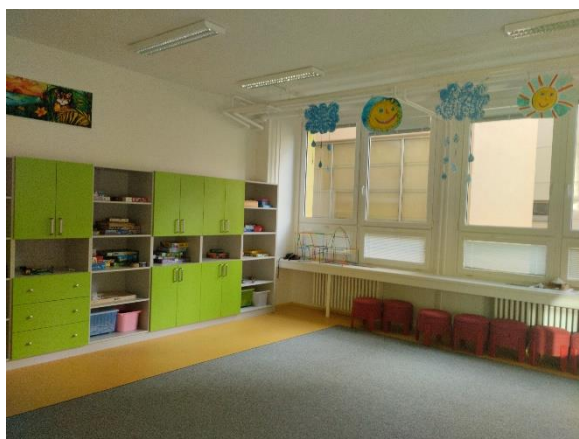
Obrázek 11 Rekonstrukce a modernizace učeben školní družiny – ZŠ Čeladná
