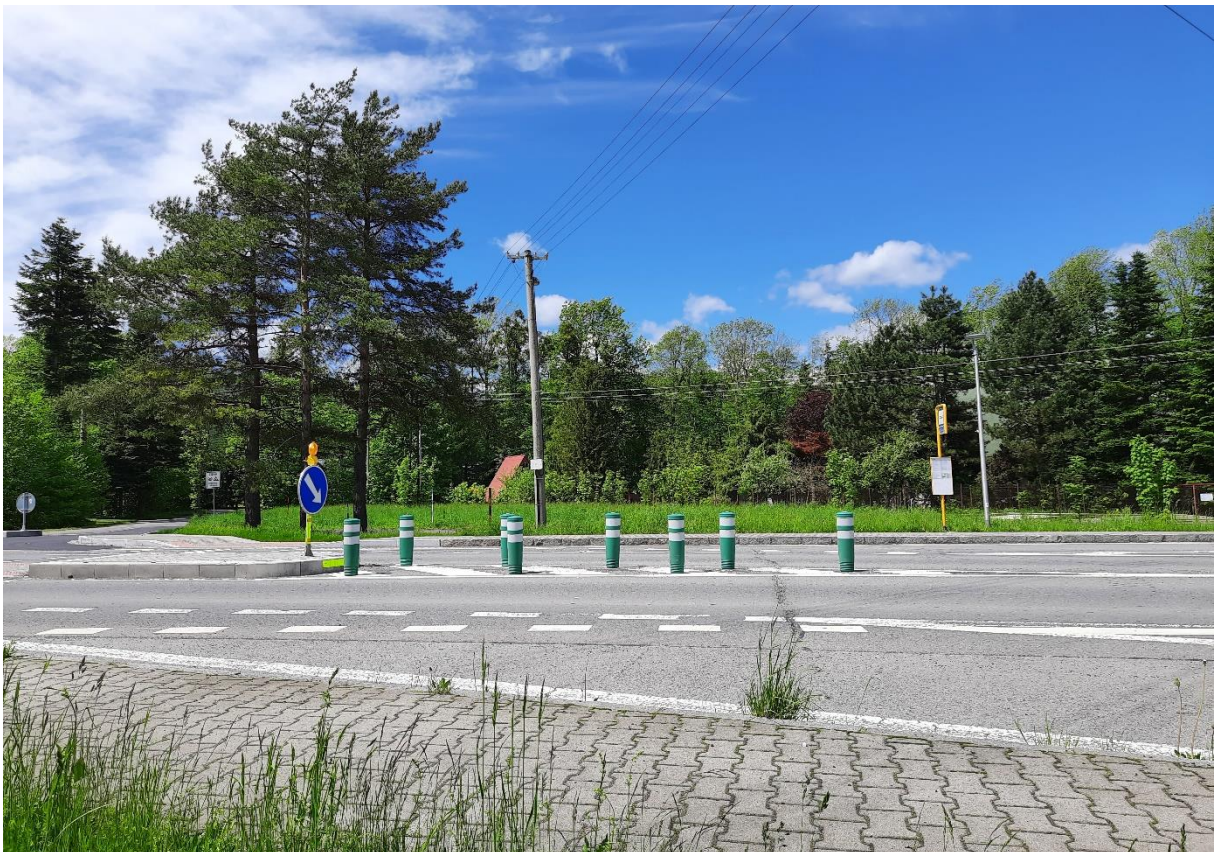
Obrázek 10 – Vybudování chodníku v obci Psruží
